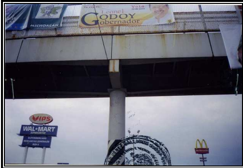
LONA UBICADA EN PUENTE PEATONAL FRENTE A CENTRO COMERCIAL WALL MART SUPER CENTER EN CALZADA LA HUERTA, DE LADO, VINIENDO DE XANGARI AL CENTRO.
