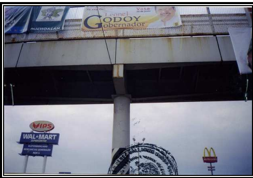
LONA UBICADA EN PUENTE PEATONAL FRENTE A CENTRO COMERCIAL WALL MART SUPER CENTER EN CALZADA LA HUERTA, DE LADO, VINIENDO DE XANGARI AL CENTRO.
